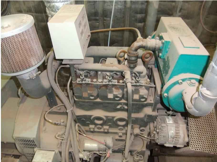
Abbildung 38: Staubbelastung nach 2 monatigem Betrieb an einer BHKW-Anlage in einem Ziegeleibetrieb (trotz G4 Filter und Frischluftansaugung über Dach)
