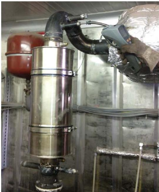
Abbildung 31: Partikelfilter, eingebaut
