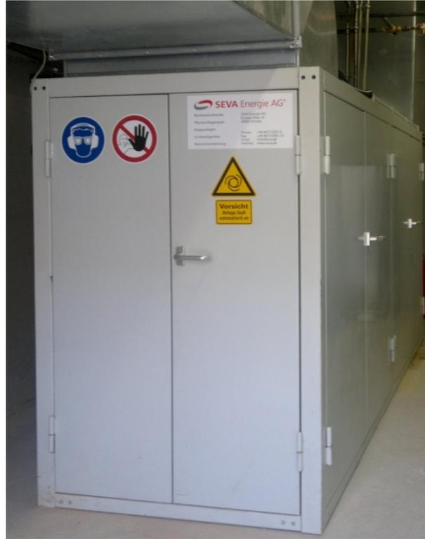
Abbildung 37: Schalldämmhaube eines BHKWs mit 140kW<sub>el</sub> Leistung, geplant vom SIZ
