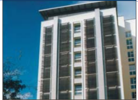
Abb. 2: Fassade mit Vakuumröhrenkollektoren
