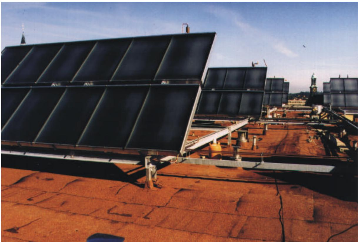
*Abb. 1: Typische Tragkonstruktion für eine große Solaranlage auf dem Flachdach eines Studentenwohnheimes (Foto: Thomas Freitag)*
