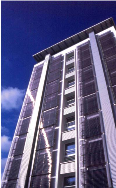
Abbildung 1: Fassadenintegration von vier nebeneinanderliegenden Modulreihen
